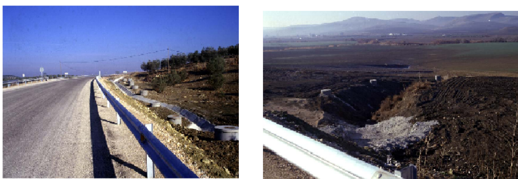
Figura 52: Alineación de pozos de drenaje en una carretera de Córdoba (Los pozos siguen bastante más allá del deslizamiento para extraer el agua por gravedad)
