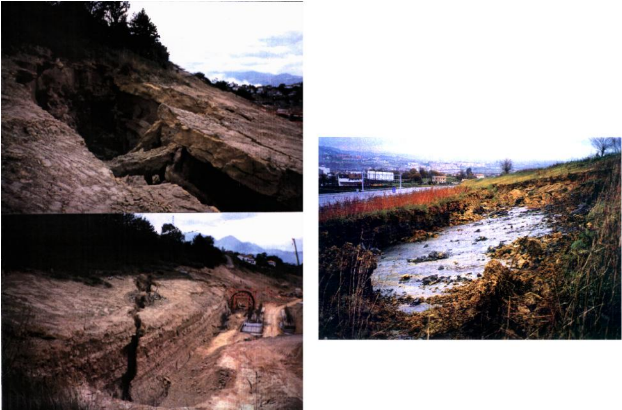
Figura 17: Deslizamientos traslacionales en la autovía del Cueto (Asturias)
