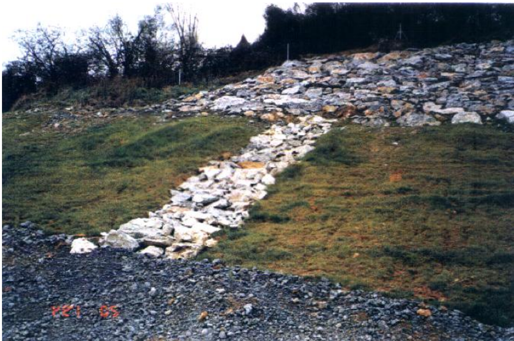
Figura 42: Encachados y zanjas de drenaje en la autovía del Cueto (Asturias) (Foto L. Ortuño).
