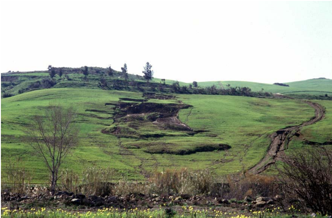
Figura 3: Reptación natural de taludes en “los Destrozos” (Málaga).
