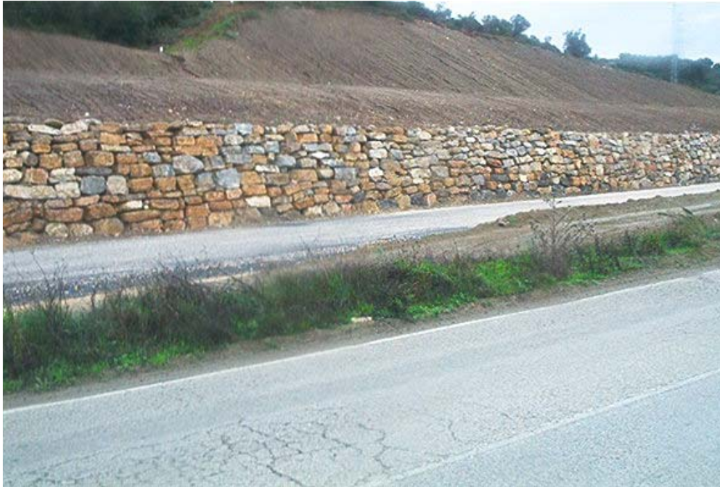
Figura 21: Muro de escollera y relleno de trasdós en desmonte. Autovía Jerez-Los Barrios (Cádiz). (Foto L. Ortuño)
