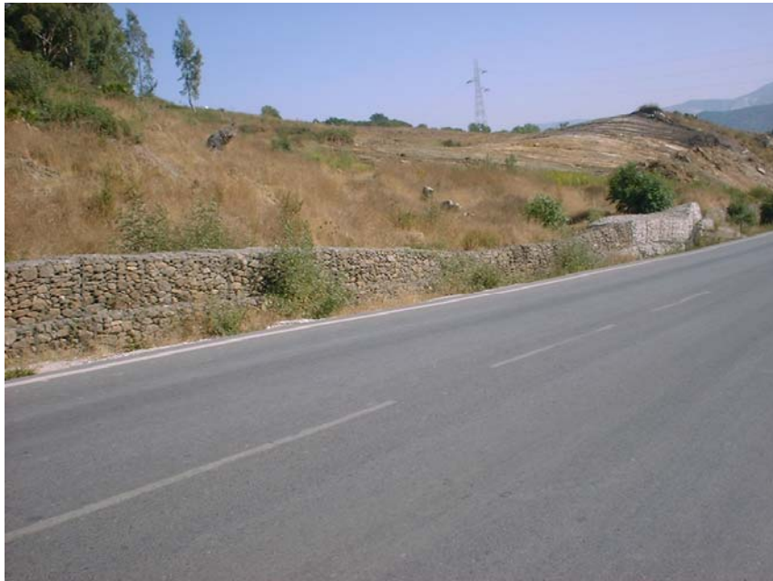
Figura 26: Flexibilidad de las contención de gaviones. Carretera Jerez-Los Barrios (Cádiz). (Foto L. Ortuño)
