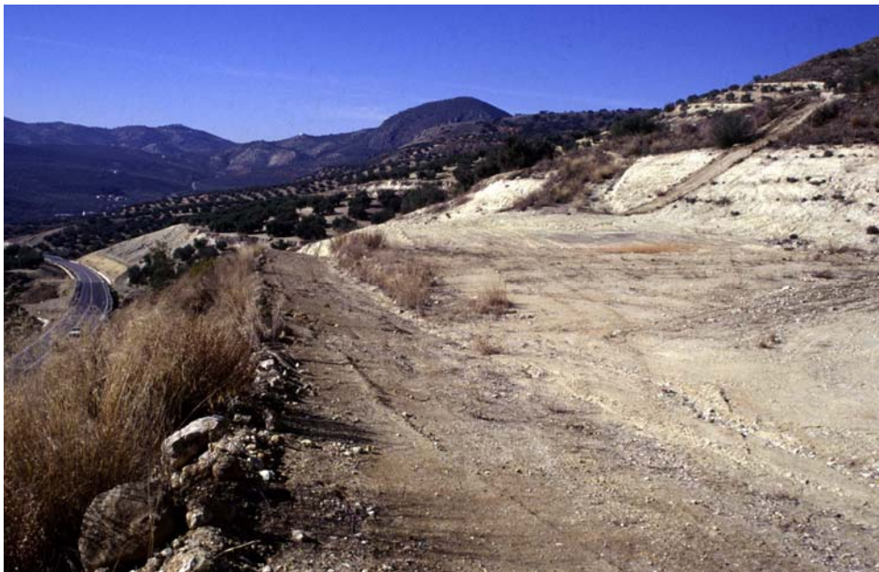
Figura 20: Proceso de ejecución de descabezado en un talud de la carretera entre Rute e Iznajar (Córdoba). (Foto L. Ortuño).
