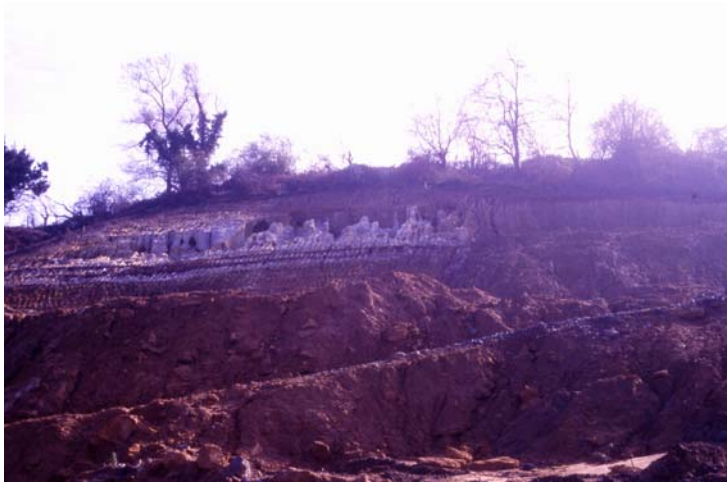
Figura 44: Mecanismos de inestabilidad en desmontes sobre arenas en la Ronda Exterior de Oviedo (Asturias). (Foto L. Ortuño).
