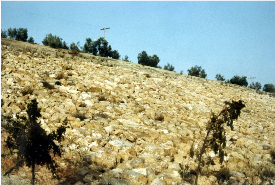
Figura 40: Encachado con pedraplén del talud mostrado en la Figura 37.
