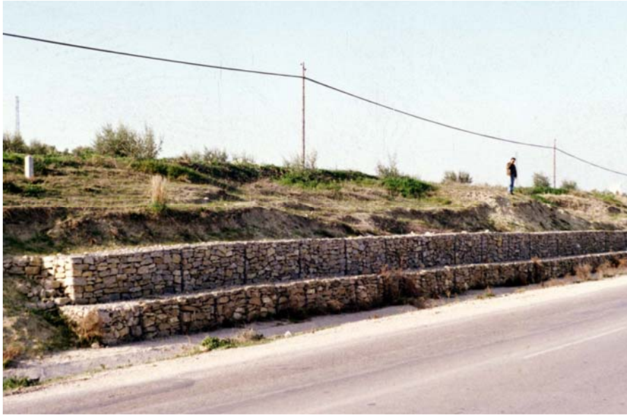
Figura 25: Contención de gaviones. Carretera Ubeda-Baeza (Jaén). Foto L. Ortuño)
