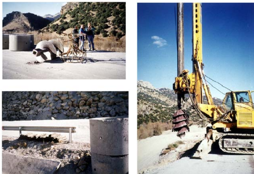
Figura 54: Detalles de ejecución de pozos. El Molinillo (Granada)
