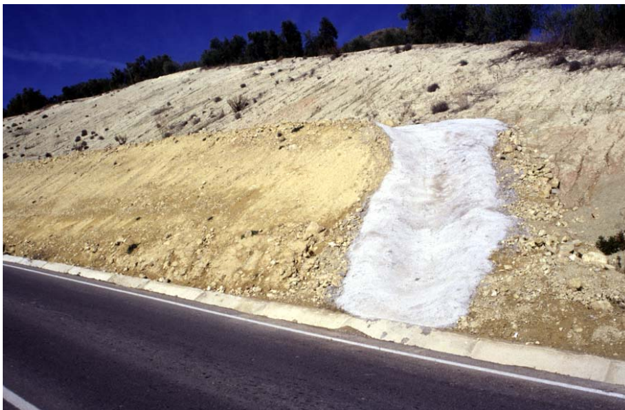
Figura 31: Detalle de la bajante para conducción de agua del relleno estabilizador de la figura anterior.
