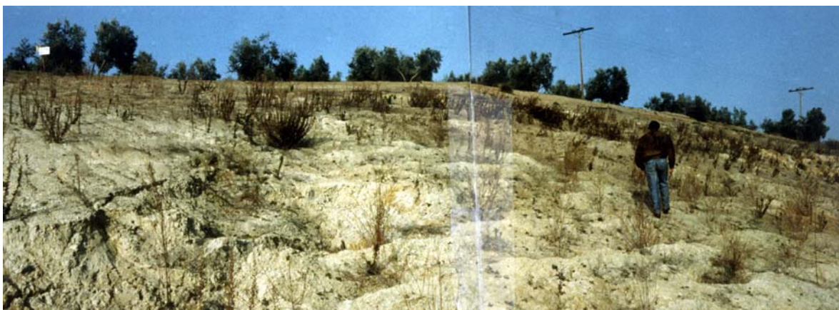
Figura 37: Deterioro y lobulación de un desmonte. Carretera de Jaén a Baeza (Jaén). (Foto Miguel Angel Oliveros)
