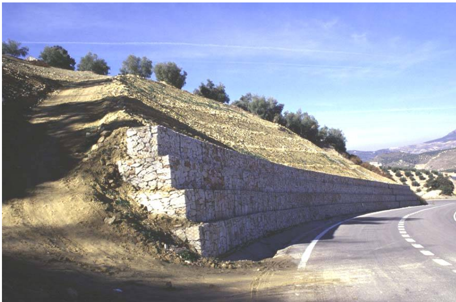
Figura 29: Muro de gaviones y relleno de trasdós en Rute-Iznájar (Córdoba). (Foto L. Ortuño).
