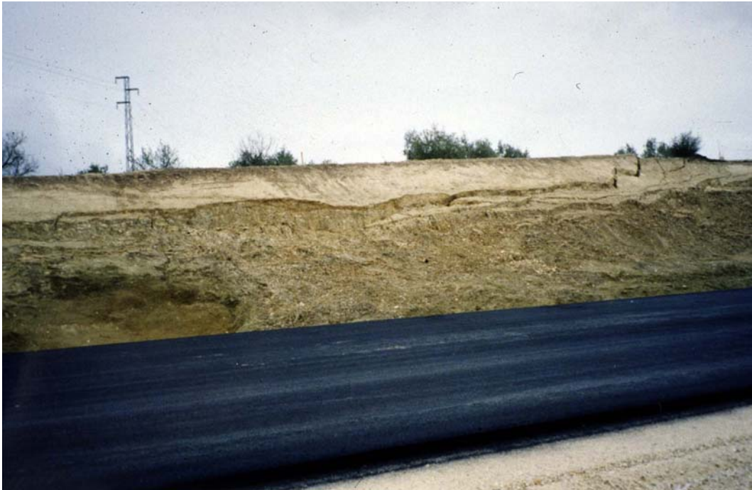
Figura 38: Deterioro generalizado de taludes de la carretera de Morón a Pruna (Sevilla). (Foto L. P).
