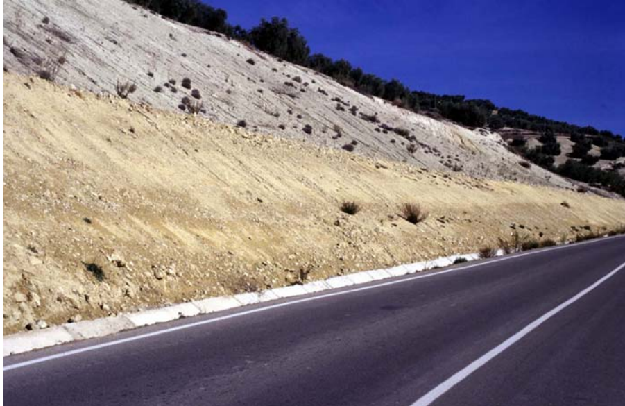
Figura 30: Ejemplo de relleno estabilizador de tierras (limitador de altura máxima del talud). Carretera de Rute a Iznájar (Córdoba). (Foto L. Ortuño).
